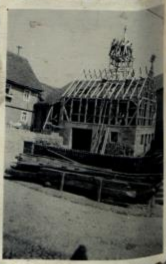
Richtfest neben der Bühne am Spritzenhaus
